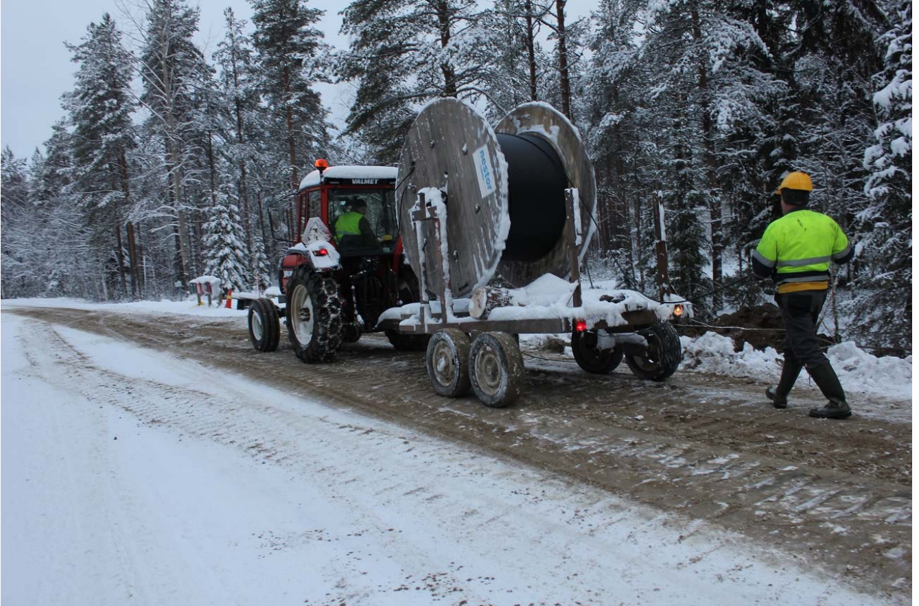
Talkootyöläisiä ja – kalustoa: Arto Malinen ja Timo Malinen levittävät kaapelia Kuuselan postilaatikoille
