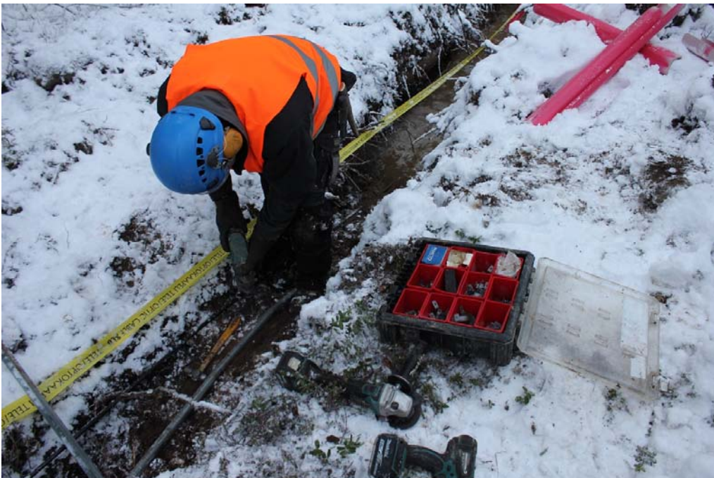
Kuva 4. Reikien poraaminen kiinnitysproppuja varten (in029.jpg)
