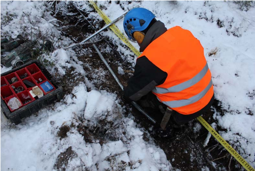
Kuva 3. Muodon viimeistely asennuskohteessa (in025.jpg)
